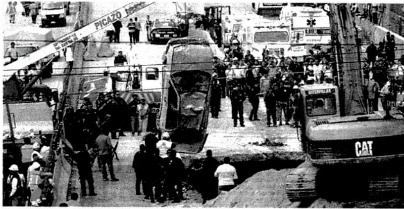
A la altura del kilómetro 93.6, de la colonia Chapiltlán, en Cuernavaca, se produjo un socavón por las lluvias en el que un auto cayó y sus dos pasajeros murieron.
