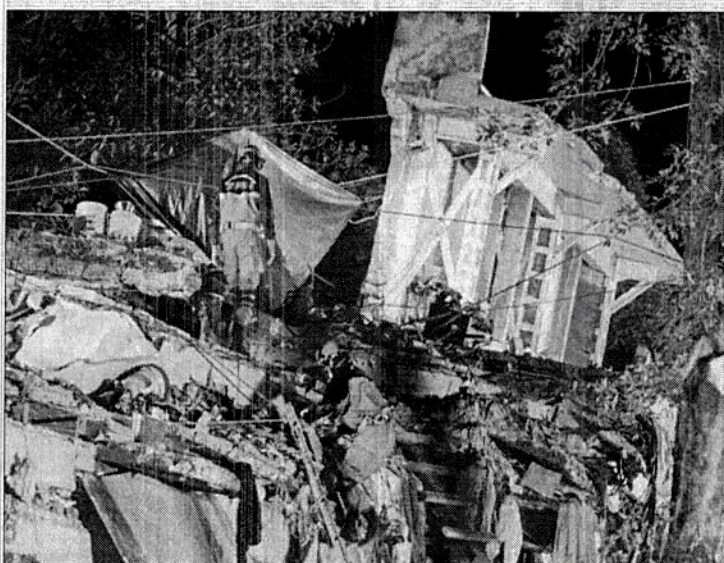
Durante el fin de semana, prosiguieron las labores de rescate en los diferentes sitios donde el temblor provocó derrumbes y personas quedaron atrapadas entre escombros. En Talpan y Taxqueña, brigadistas japoneses buscan a personas en edificios colapsados. FOTO DE GILBERTO MARQUINA
