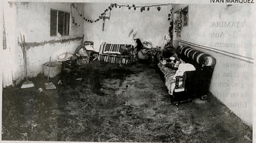
LAS LLUVIAS afectaron incluso el interior de las casas
