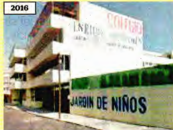
2016 Para diciembre de 2016, se podía observar una pérgola, de un departamento, cuya obra no fue verificada.
