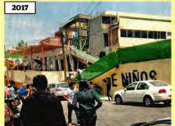
2017 Con el terremoto del 19 de septiembre el edificio colapsó; 27 personas murieron: 19 niños y 8 adultos.
