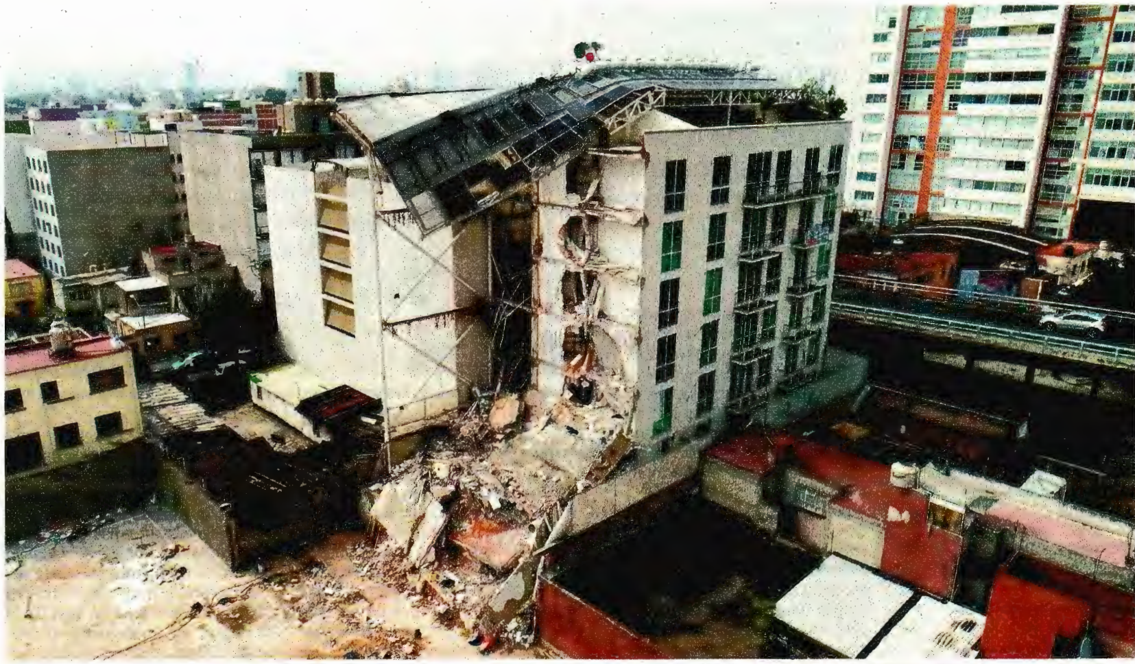
Seis departamentos de Residencial San José, en Zapata y Tlalpan, de la colonia Portales, se derrumbaron por el sismo. El edificio es de reciente construcción.
