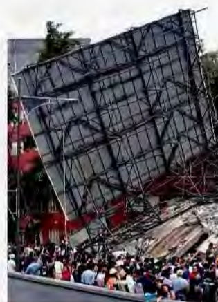
Edificio colapsado en Viaducto y Torreón
