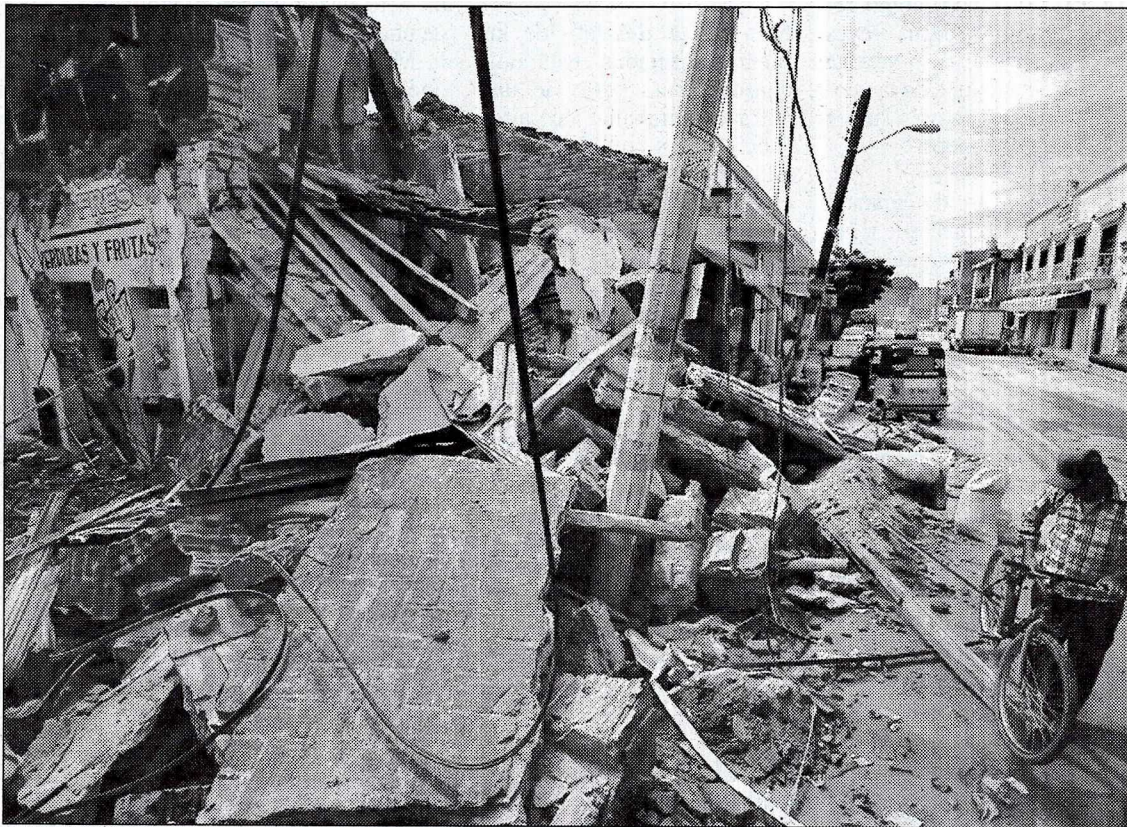
Autoridades estatales y federales levantarán un censo de viviendas dañadas en la región del Istmo de Tehuantepec, Oaxaca, con la finalidad de inscribir a las familias en un programa de reconstrucción ■ Foto Alfredo Domínguez
