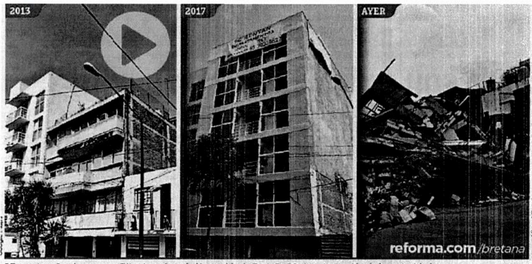
■ En cuatro años, la empresa Dijon transformó el inmueble de Bretaña 90 sin autorización de las autoridades.
