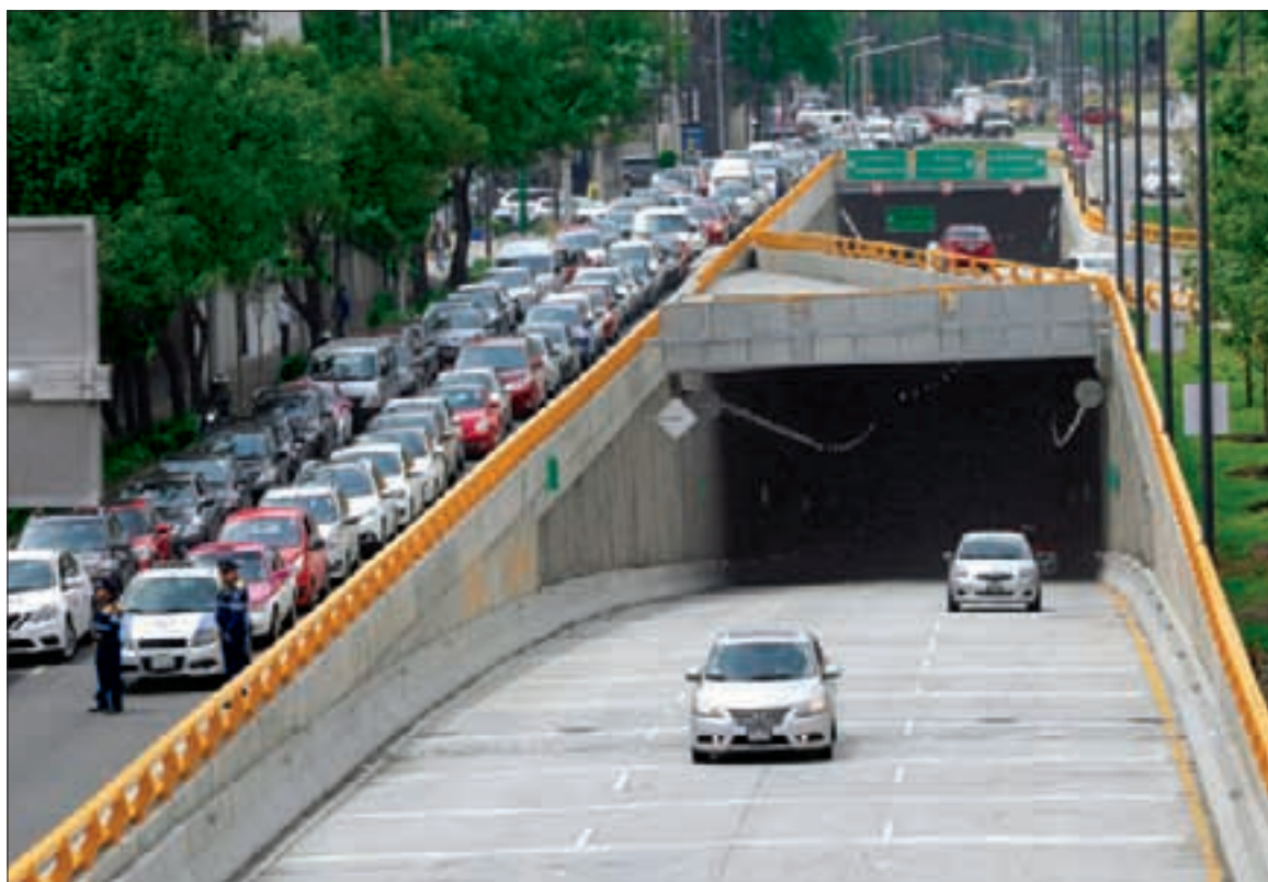
Luego de la apertura del túnel Mixcoac-Insurgentes, el tráfico en esa zona fue intenso. Los conflictos viales se generaron en carriles laterales de Mixcoac, para quienes procedían de la avenida Insurgentes hacia Universidad. .14 y 15
