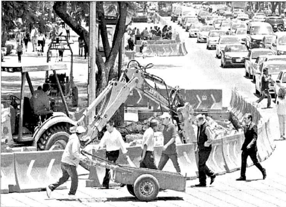
Las obras de la línea 7 del Metrobús en Paseo de la Reforma han ocasionado severos problemas viales. La imagen fue tomada ayer desde el Ángel de la Independencia ■ Foto María Luisa Severiano
