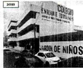
En septiembre de 2015, la construcción en la parte superior del edificio se amplió hacia afuera.
