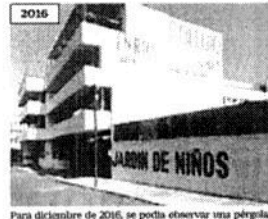
Para diciembre de 2016, se podía observar una pérgola, de un departamento, cuya obra no fue verificada.
