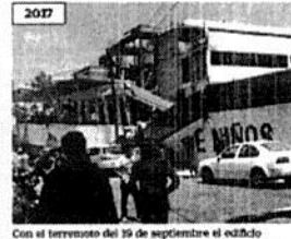
Con el terremoto del 19 de septiembre el edificio colapsó; 27 personas murieron: 19 niños y 8 adultos.
