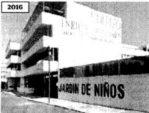
2016 Para diciembre de 2016, se podía observar una pérgola, de un departamento, cuya obra no fue verificada.
