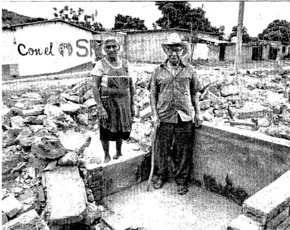
En Cintalapa, Chiapas, Luz García López y su esposo, Alfonso Rodríguez Clemente, contemplan lo que fue su vivienda. Elementos de la Marina trabajan en el derribo de 170 casas afectadas por el sismo en el ejido Lázaro Cárdenas de ese municipio. Los habitantes de esa comunidad aseguran que a las más de 400 familias damnificadas sólo les ha llegado una pequeña despensa del DIF estatal ■ Foto Moisés Zúñiga Santiago
