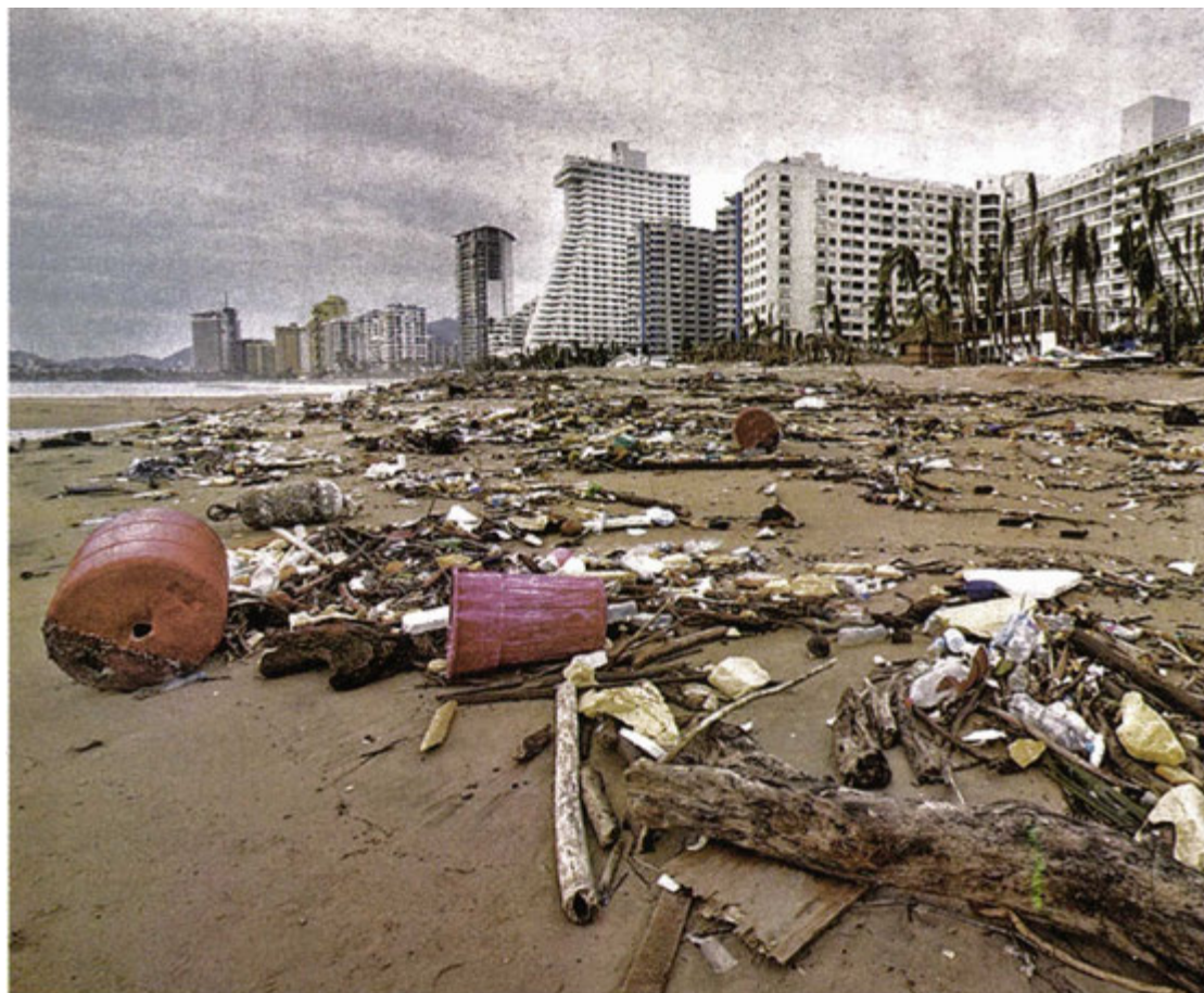
Severos daños en la zona hotelera de Acapulco. AP
