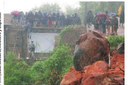
GN atiende deslizamientos de tierra.
