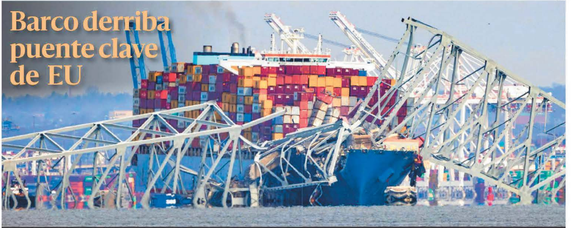
El buque de carga con 10 mil contenedores quedó incrustado entre el hierro del puente colapsado debido a la colisión. La nave había salido del puerto de Baltimore.
