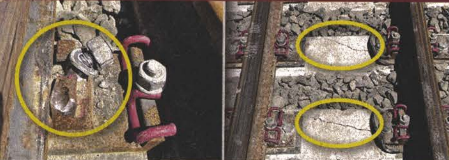
En la imagen se observa la falta de sujetadores en los rieles.
