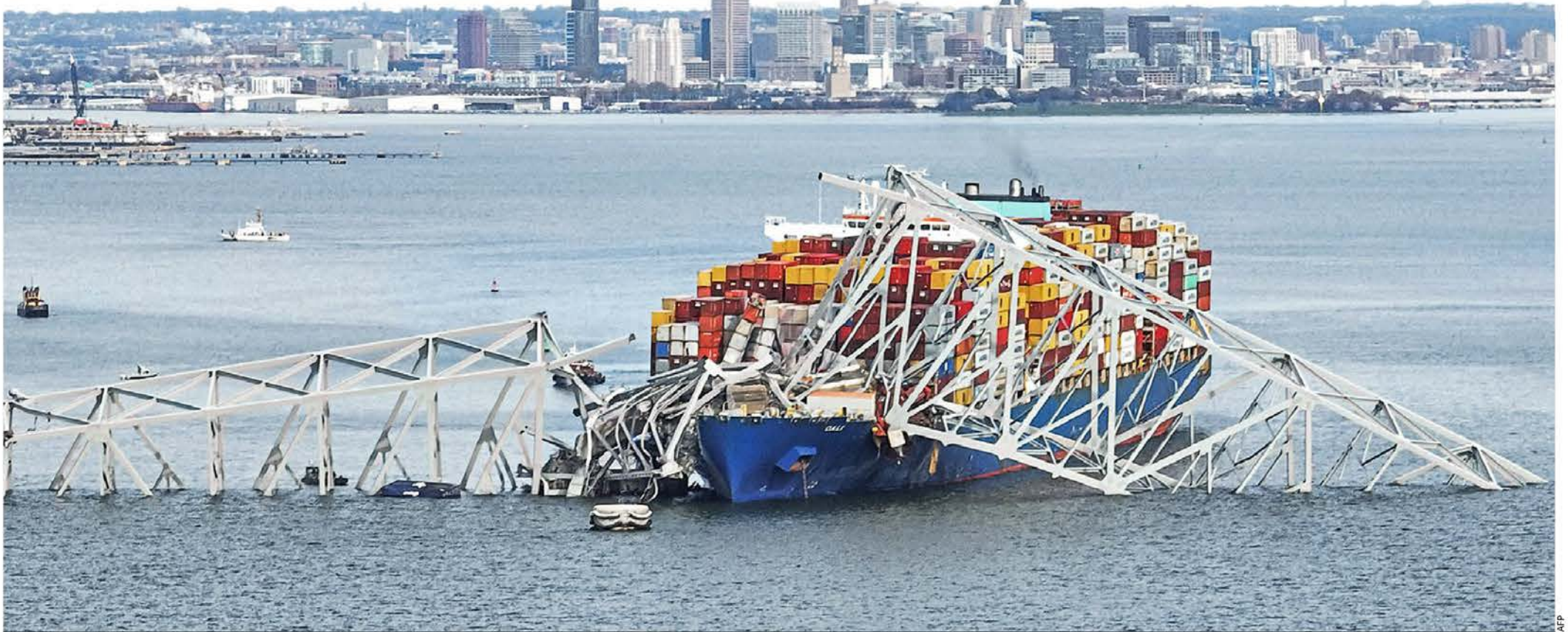
COLAPSO EN BALTIMORE. Un buque chocó contra un puente en EU, tras una falla eléctrica. La Guardia Costera suspendió el rescate de 6 desaparecidos, al menos uno mexicano MUNDO P. 16
