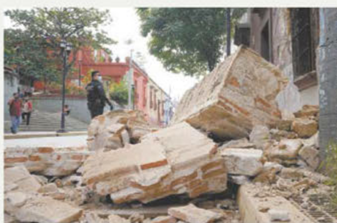
En el estado de Oaxaca se registraron derrumbes en carreteras y daños en viviendas, zonas arqueológicas y centros de salud.
