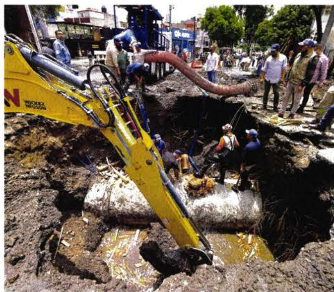
Personal de Sacmex y Protección Civil trabaja en la reparación del socavón que se abrió en Canal de Miramontes.
