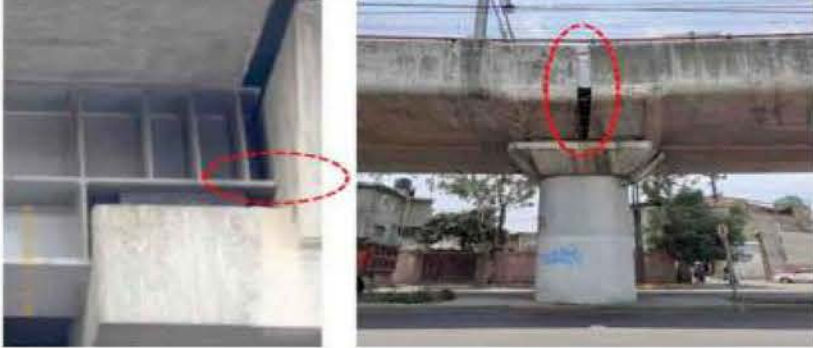
Separación insuficiente de vigas entre ellas y respecto a los cabezales
