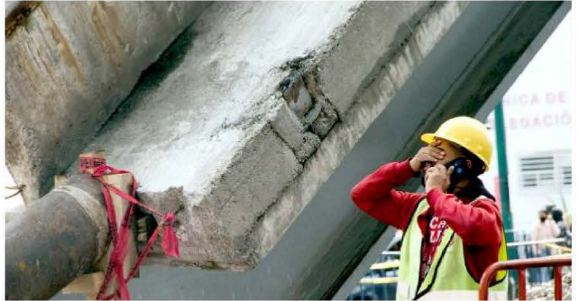
Fisuras en traveses y cabezales Fisuras en columnas
