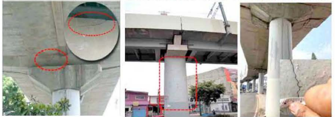
Fisuras en traveses y cabezales Fisuras en columnas
