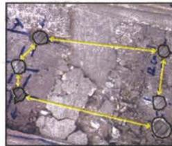
**04** Cantidad de pernos menor a la requerida, distancia de separación no uniforme y la falta de eliminación de la cerámica de protección, que incumple con los planos de la obra.
