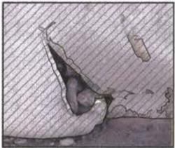
**01** Deformación y fractura en las vigas que conforman el puente de concreto-acero en las travesías sur (sección sobre la cual rodaba el tren en el momento del accidente), norte y la de la bifurcación.
