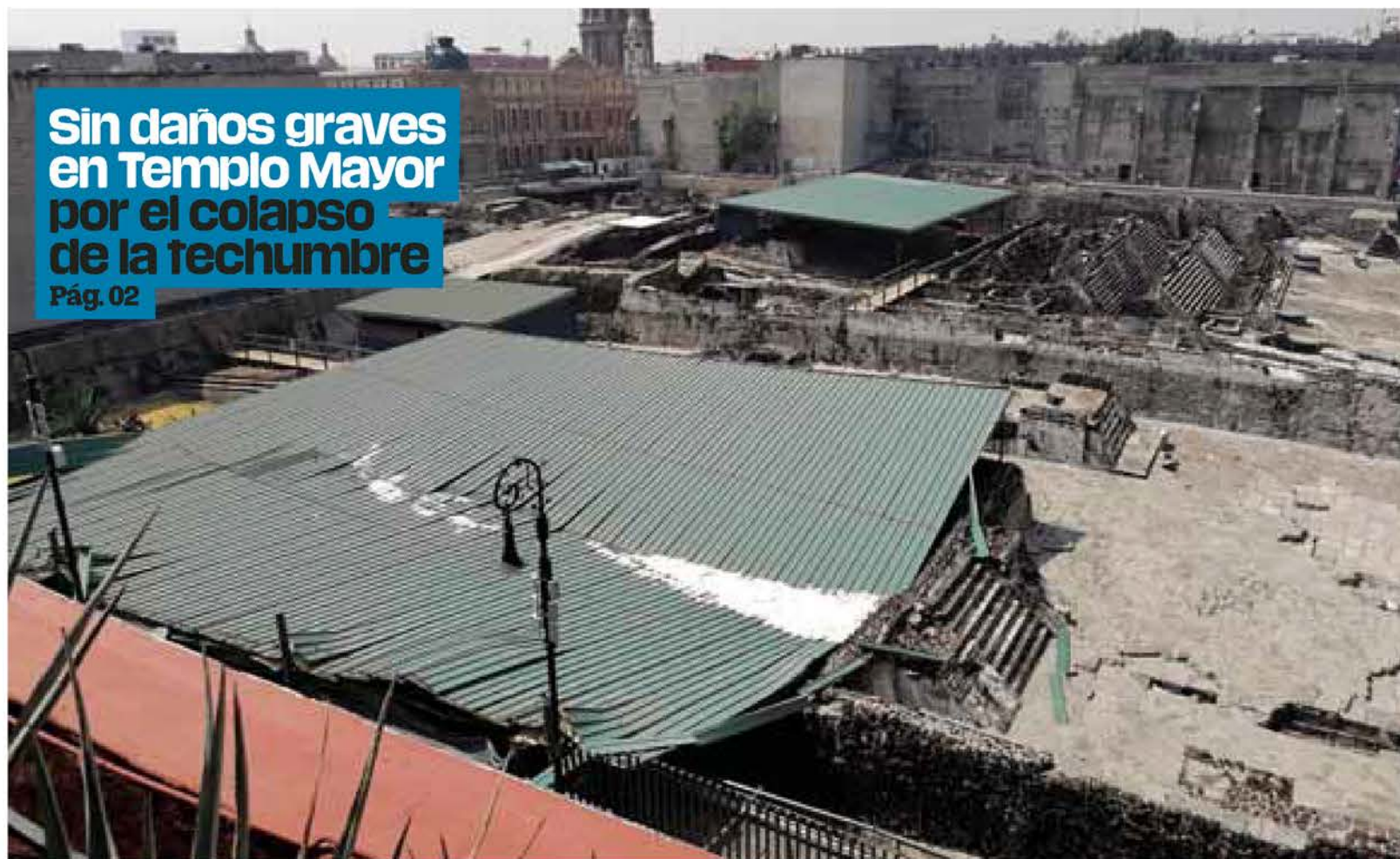
CDMX. Las autoridades preparan un plan emergente para cubrir la zona en esta temporada, antes de cambiar las estructuras. / NICOLÁS CORTE
