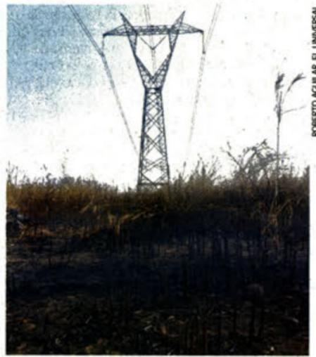
La estructura de las torres de transmisión no muestra signos de daño por fuego.
