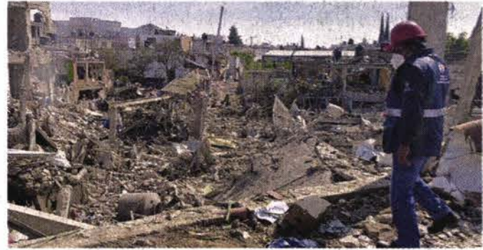
Protección Civil evaluó los daños materiales provocados por tres explosiones subsiguientes en un ducto ordeñado.
