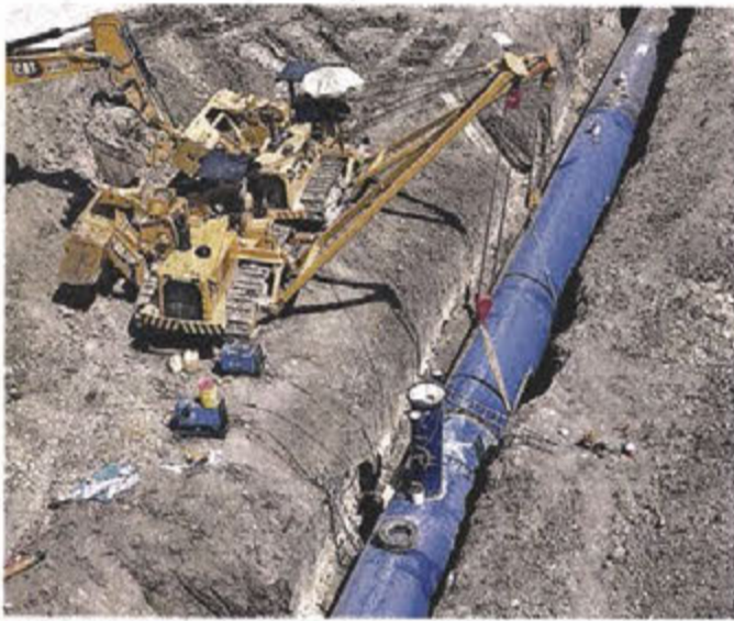
Un segmento del ducto, atrás de la Refinería de Cadereyta, es sostenido por dos grúas para apenas ser unido ayer.
