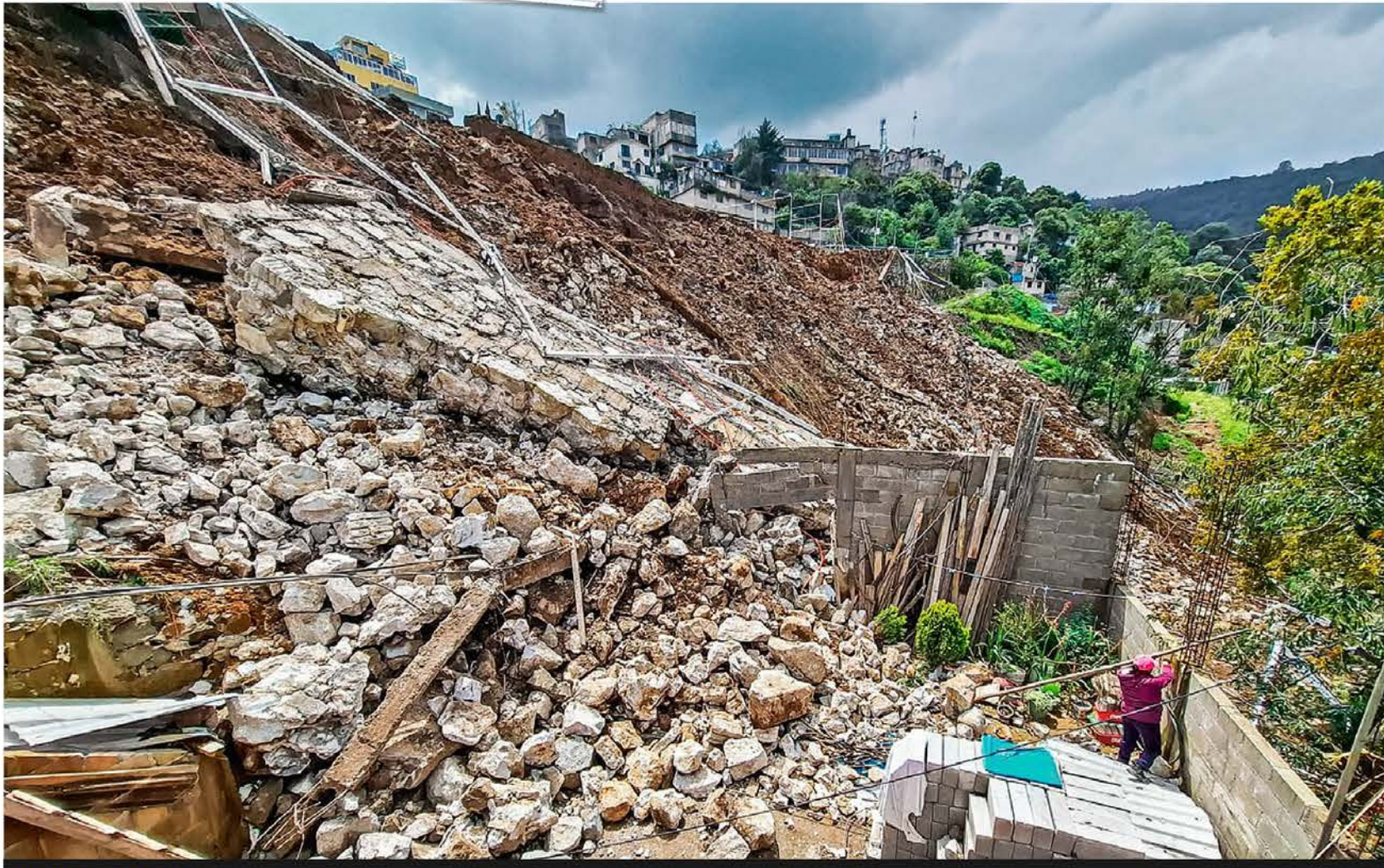
VULNERABLES. Un nuevo derrumbe en la colonia San Francisco Chimalpa, en Naucalpan, cobró la vida de un elemento de Protección Civil, con lo que suman 16 decesos en el Edomex. Las fuertes lluvias colocan a los habitantes de zonas altas en un panorama de indefensión ESTADOS P. 12
