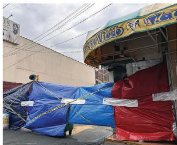
INSTALACIONES de El Borrego Viudo, en Tacubaya, ayer.
