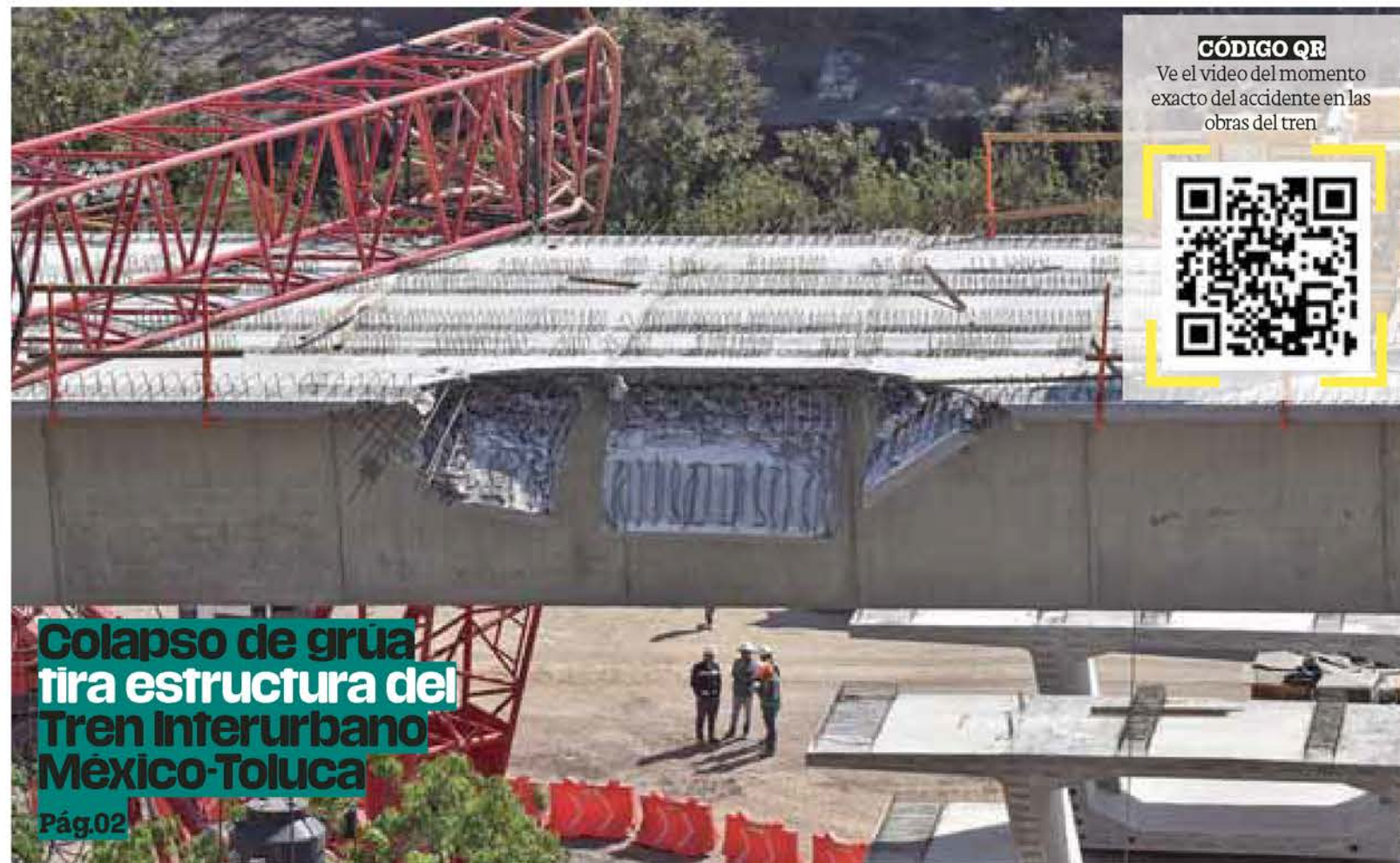
CDMX. Una dovela de las obras del tren interurbano cayó sobre dos vehículos después de que una grúa colapsara, en la zona de Observatorio. / CUARTOSCURO
