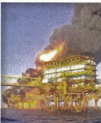
JULIO, 2023. Plataforma Nohoch-A en Cantarell, en Campeche.
