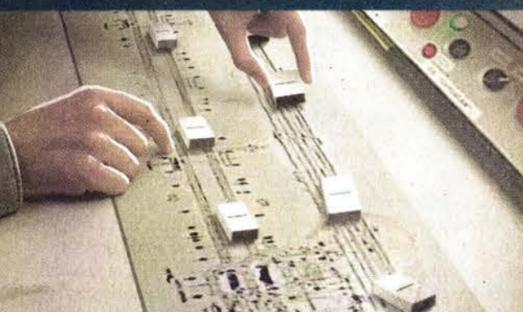
Desde el Puesto Central de Control del Metro, los controladores acomodan las fichas de dominó para simular el desplazamiento y localización de trenes, conforme la indicación del conductor. Así calculan las distancias entre convoyes para evitar accidentes.
