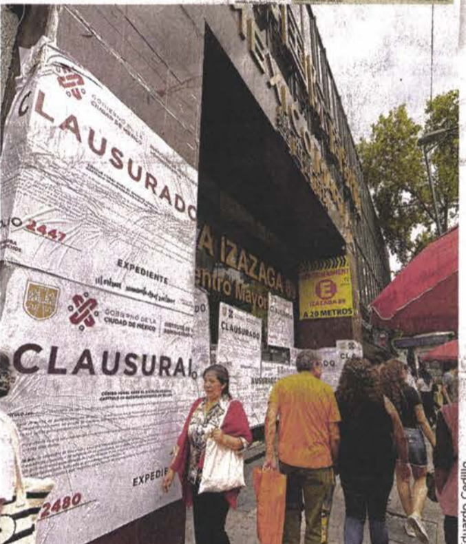
El Instituto de Verificación Administrativa (Invea) clausuró ayer la plaza "México Mart" de 16 pisos.
