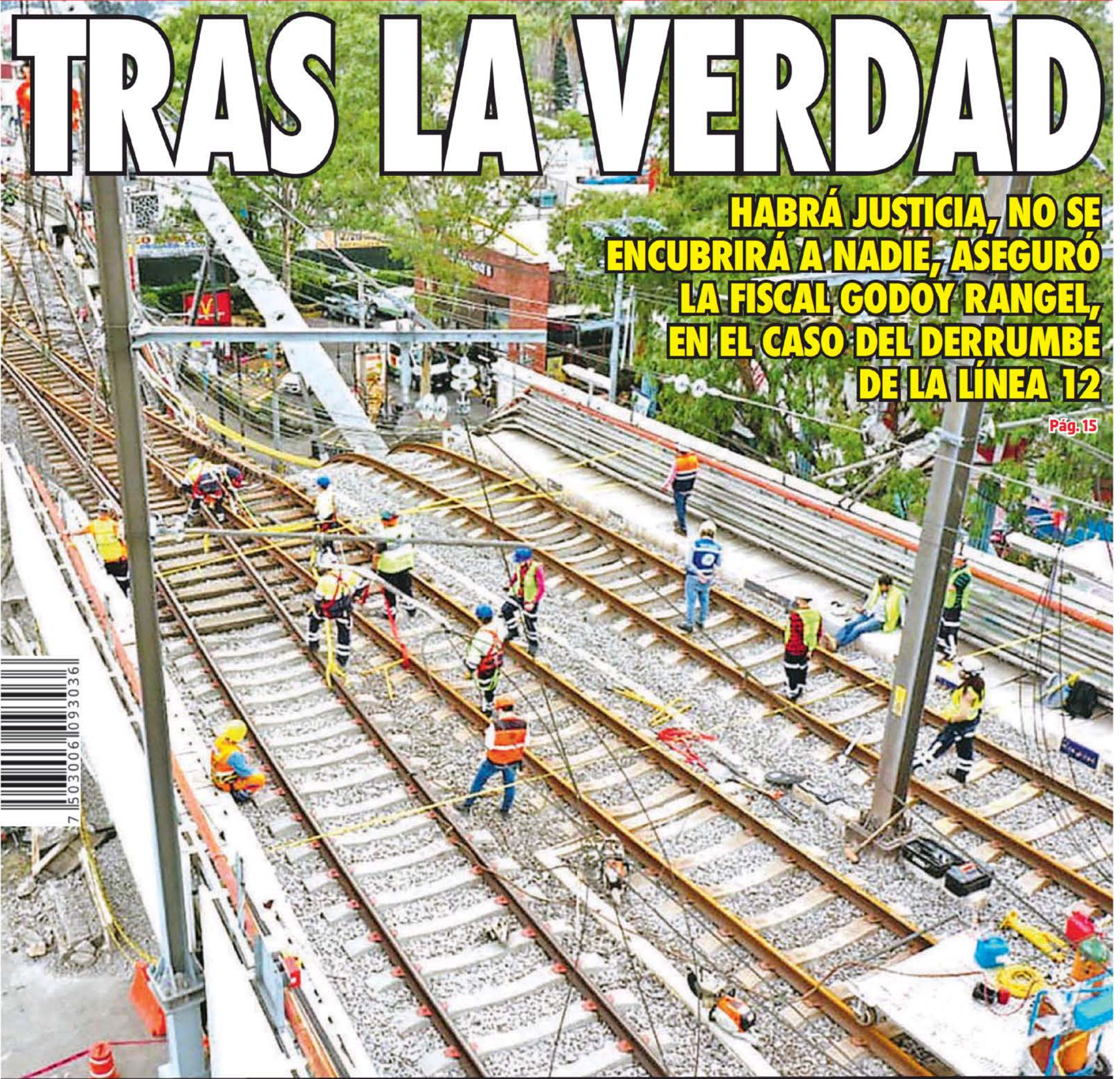
Peritos laboran en la zona cero del colapso de la Línea 12. FOTO DAVID DEOLARTE
