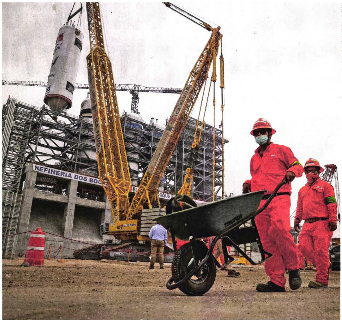
En el complejo operan más de 32 mil trabajadores para concluir la refinería Olmeca antes de su inauguración, el próximo 2 de julio. El avance en la construcción hasta ahora es de 90%.
