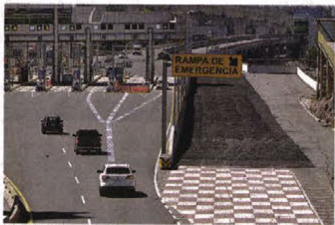
Una de las rampas de emergencia en la México-Toluca.
