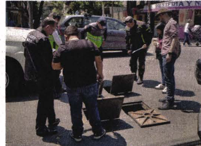
Además del análisis de la calidad de agua, se realiza desazolve del drenaje.
