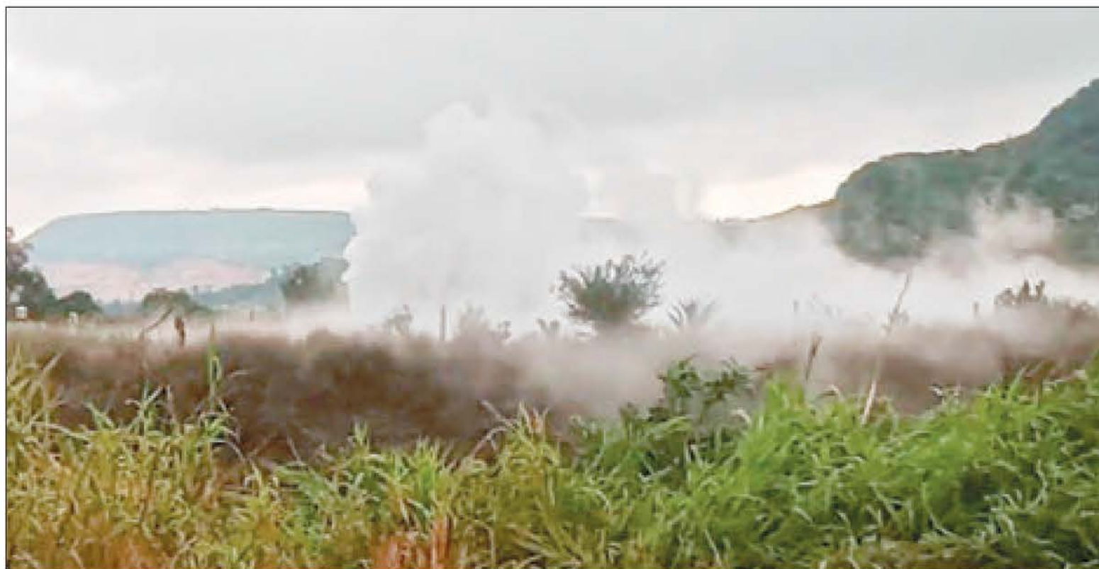
▲ La fuga en un ducto de gas LP de Pemex en la localidad Santa Ana Azcapotzaltongo, municipio de Tepeji del Río, Hidalgo, fue controlada al
