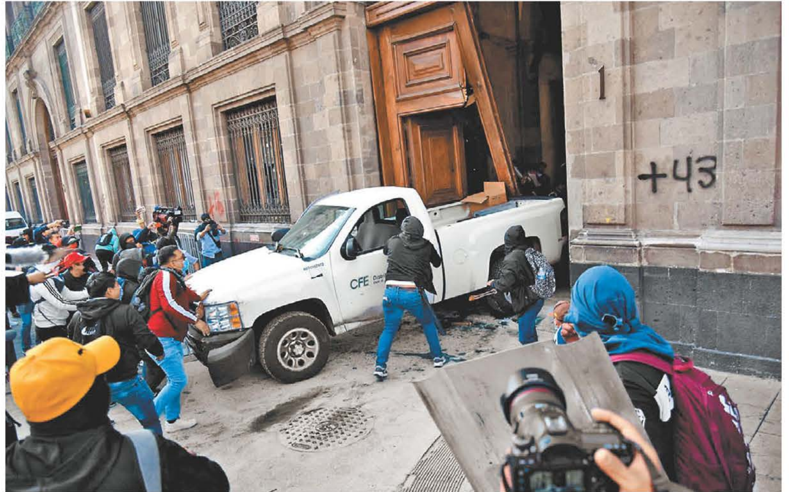
Expertos consideran que los daños al portón de la calle Moneda superan los 700 mil pesos. CUARTOSCURO
