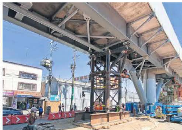
Las 13 mil toneladas de acero se han utilizado para rehabilitar el tramo elevado de la Línea Dorada que colapsó en mayo de 2021.
