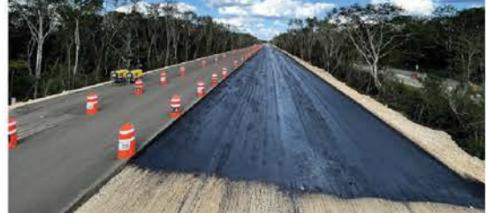
Trabajos en la vía Izamal-Cancún.
