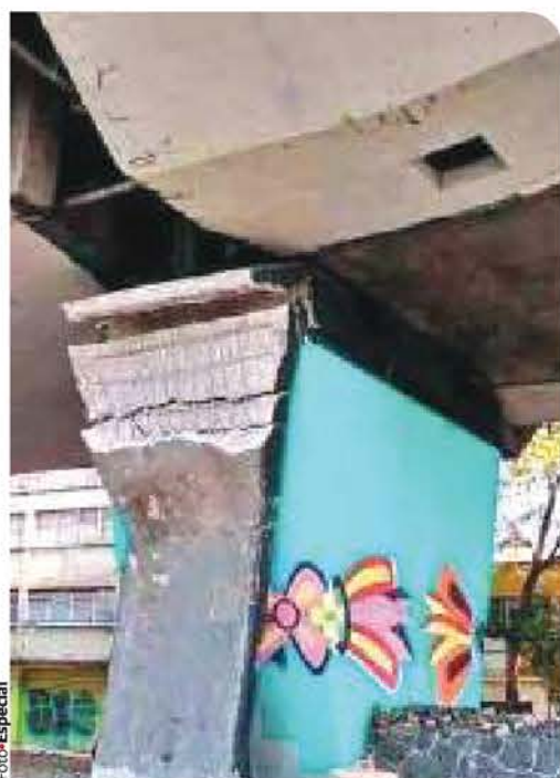
LA LÍNEA 4 DEL METRO, EN CONSULADO.
