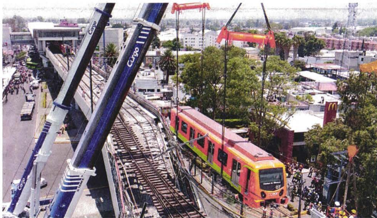
Uno de los vagones que cayó del tramo elevado de la llamada Línea Dorada fue removido con dos enormes grúas para trasladarlo a los talleres del Metro. Autoridades cercaron el perímetro para evitar más accidentes.
