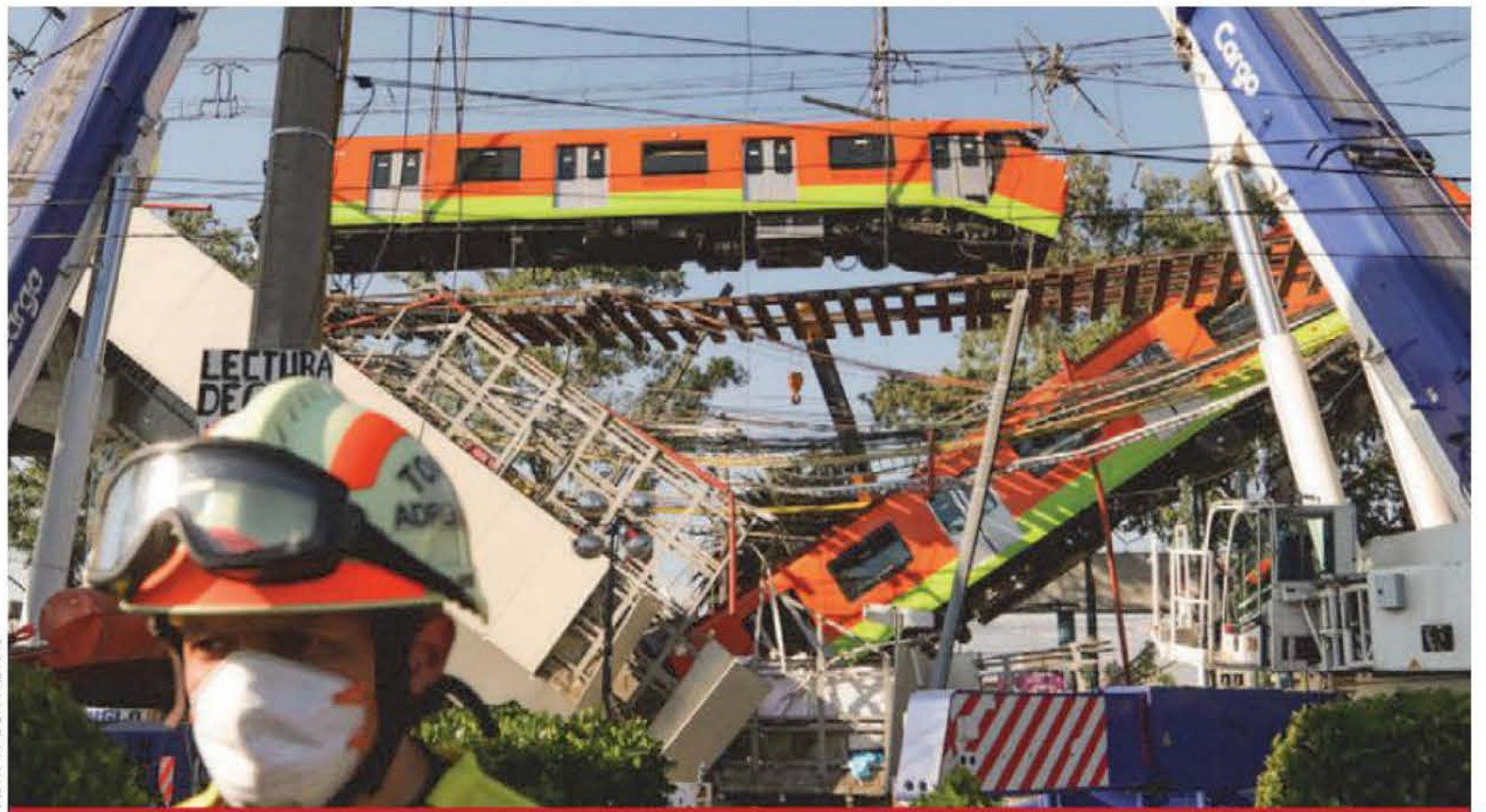
Gigantescas grúas movieron del lugar del accidente a los dos vagones desplomados de la Línea 12 en la estación Olivos
