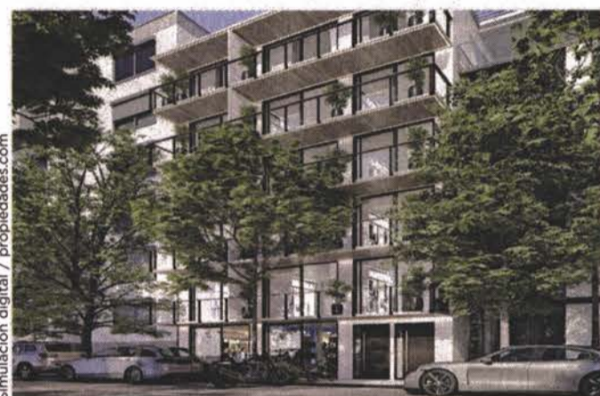
Vecinos denunciaron que fueron construidos pisos extra en Oaxaca 33 sin los permisos legales.
