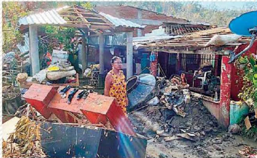
En Ejido Viejo la gente no termina de limpiar. Calles y casas fueron invadidas por el lodo.
