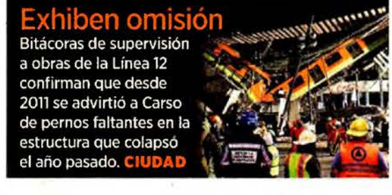
Exhiben omisión Bitácoras de supervisión a obras de la Línea 12 confirman que desde 2011 se advirtió a Carso de pernos faltantes en la estructura que colapsó el año pasado. CIUDAD
