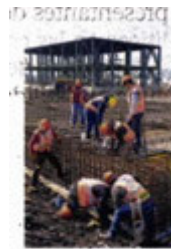
Obras del Trolébus
